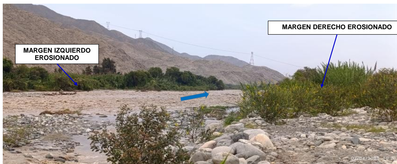
FIGURA N°04: CAUCE DEL RIO CHANCAY -HUARAL, CON EL CAUCE COLMATADO CON FLUJO DE DETRITOS Y CON LOS DIQUES EROSIONADOS POR EL
