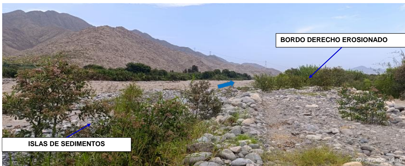
FIGURA N°03: CAUCE DEL RIO CHANCAY-HUARAL, CON EL CAUCE COLMATADO CON FLUJO DE DETRITOS Y CON LOS DIQUES EROSIONADOS POR EL CAUDAL, TRAMO DE RIO CON RIESGO A DESBORDES HACIA LA MARGEN DERECHA.
